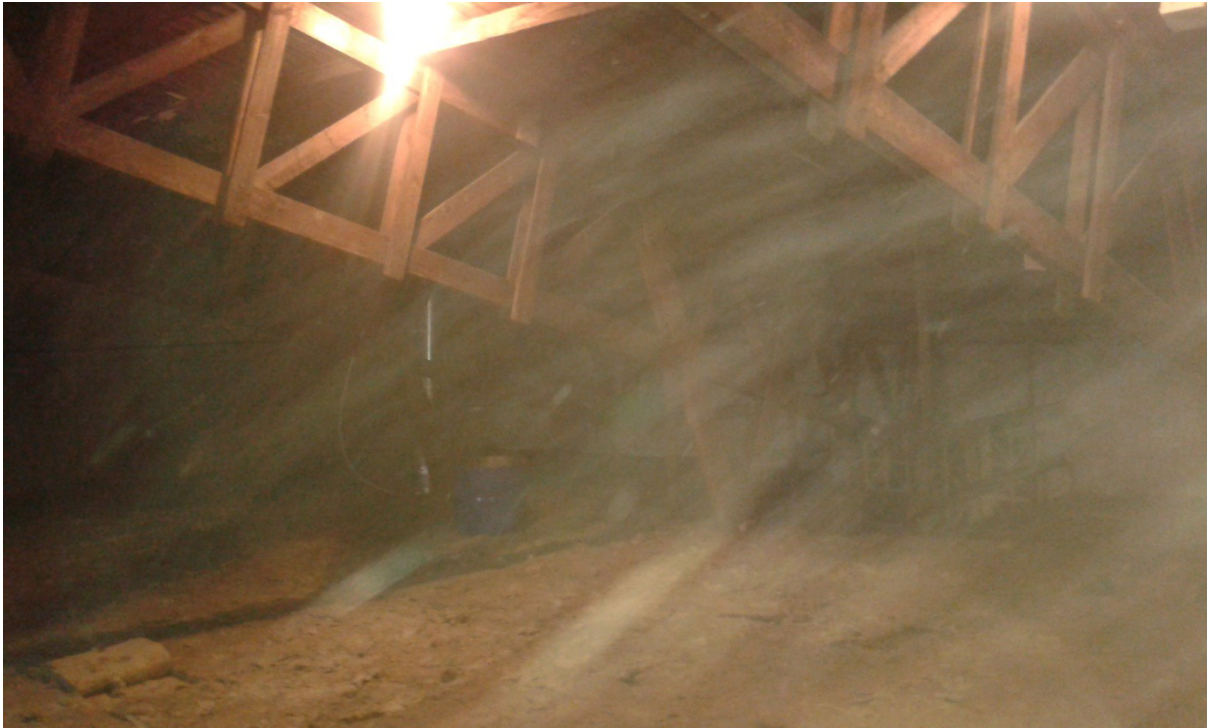
Fot. Widok konstrukcji dachu auli od ul. Grunwaldzkiej – kratownice drewniane co ok. 3.30m.
