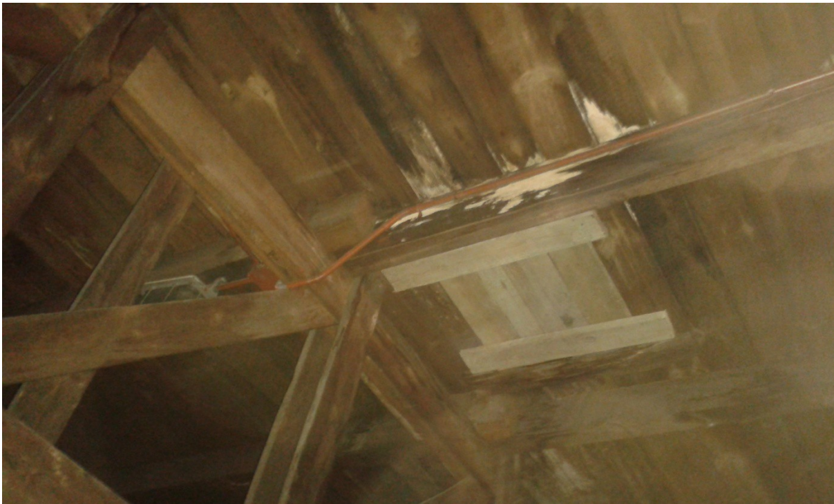
Fot. Widok zawilgoconych elementów więźby dachowej.
